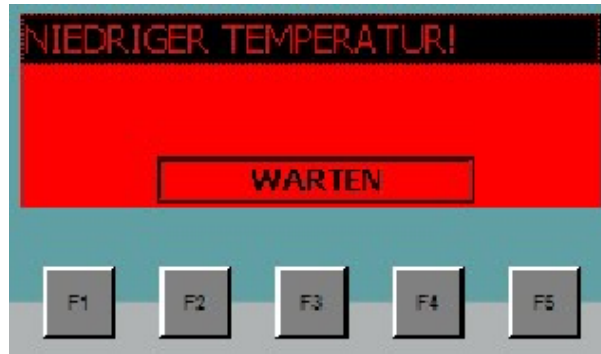
Fig. 18: Message d'alarme BASSE TEMPÉRATURE
